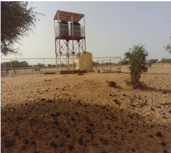
Figure 11 - Ouvrage hydraulique à destination de troupeaux, LAC TCHAD (Crédits GIST)
